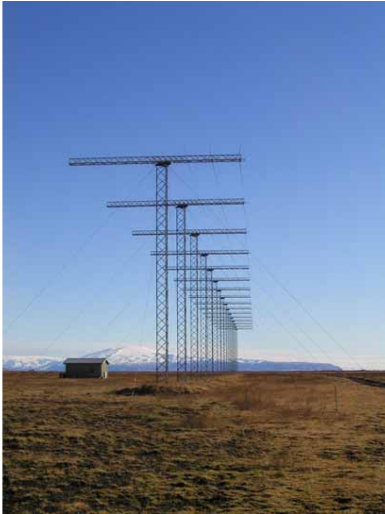
Iceland Eastレーダーアンテナ
