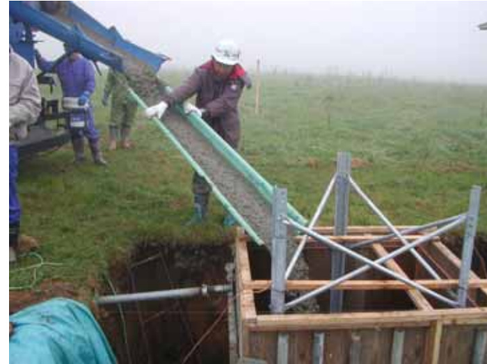
組んだ型枠にコンクリートを流し込む (2005.10.13)
