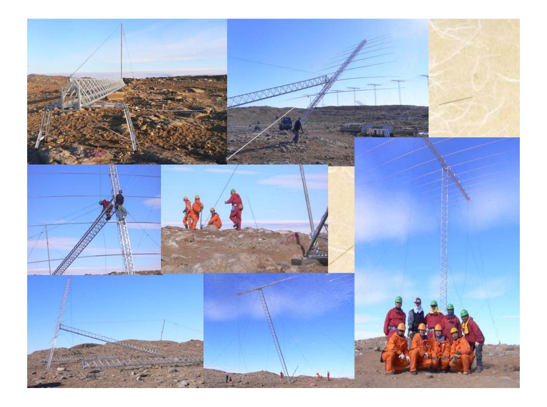
● 2 基運用 基地主要部から約1kmの2サイト 2基間も1km弱の距離 電力線/光netで基地主要部と接続 (backup回線の確保重要) 2基運用の為のRadopsの改修 (同一QNXnet上で2 Radops走る) 2基間の電波干渉の抑制(freq/blanking)
