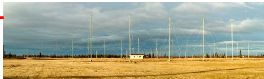
NICTがアラスカのキングサーモンに設置した大型HFレーダー
